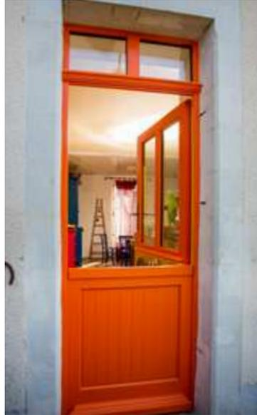
bénéficie d'une ouverture indépendante de la partie haute par un bouton au centre de la porte. La manœuvre de la poignée verrouille automatiquement les deux vantaux et permet l'ouverture de la partie haute et basse simultanément.
