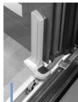
Rail de roulement en bas et rail de guidage en haut
